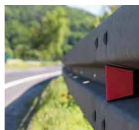
Rys. 2. Element U-1c czerwony po prawej stronie jezdni
