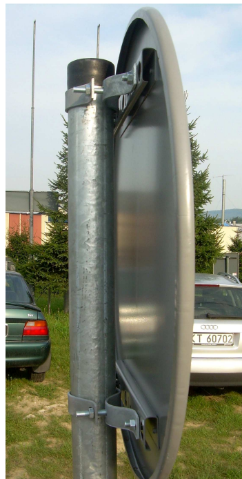
Fot. 2.13. Znak drogowy zamontowany na słupku za pomocą uchwyty typu „Fala”
