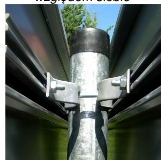
Fot. 2.19. Tablica zamontowana do słupka – widok z boku
