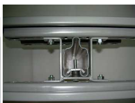
Fot. 6.4. Prawidłowo zamocowane tablice na słupku
