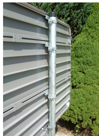
Fot. 3.15. i 3.16. Tablica zamontowana do słupka za pomocą uchwytów typu „Zacisk”
