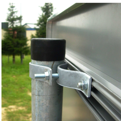
Fot. 2.7. Tablica zamocowana do słupka – widok od strony śruby
