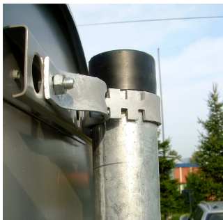
Fot. 2.10. Uchwyt uniwersalny – widok od strony zębka
