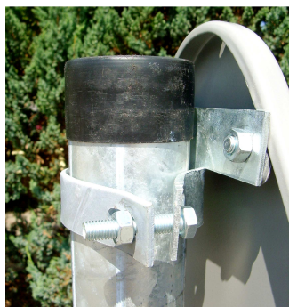
Fot. 3.5. Uchwyt typu „Zacisk” – widok od strony śruby
