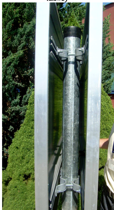
fot. 2.17. Tablica dwustronna zamontowana do słupka za pomocą uchwytu typu „Fala” – widok z boku
