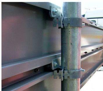
Fot. 3.9. Uchwyt typu „Zacisk” zamocowany do tablicy – widok od strony ząbka
