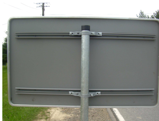
Fot. 2.8. Tablica zamontowana do słupka – widok od strony tylnej
