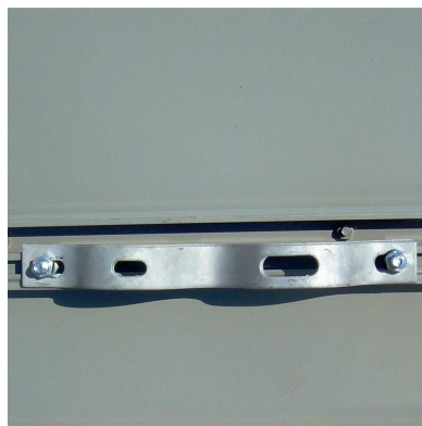
Fot. 2.14. Uchwyt zamocowany do profilu na tablicy
