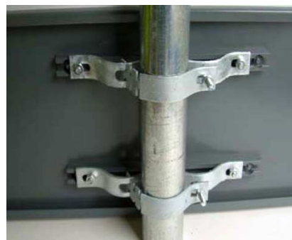
Fot. 2.4. Znak z profilem zamontowany przy pomocy uchwytu uniwersalnego
