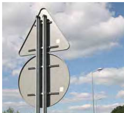
Fot. 5.1. Zamontowane znaki na słupkach
