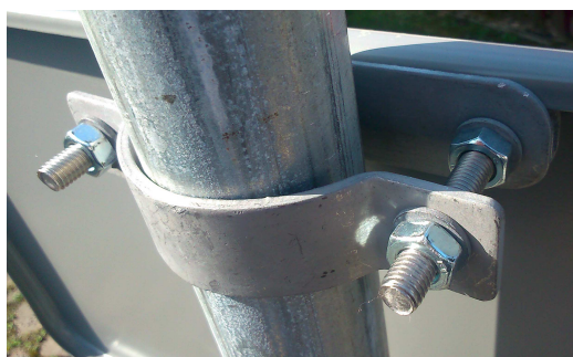
Fot. 7.2. Znak zamontowany na słupku
