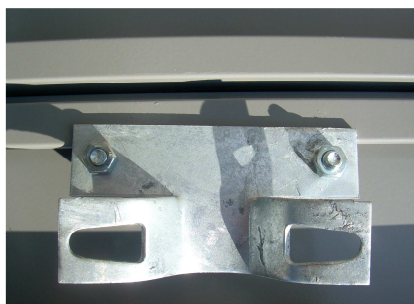
Fot. 3.12. Uchwyt zamocowany do profilu montażowo-usztywniającego
