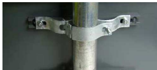
Fot. 3. Uchwyt uniwersalny przykręcony do słupka
