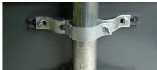
Fot. 3. Uchwyt uniwersalny przykręcony do słupka
