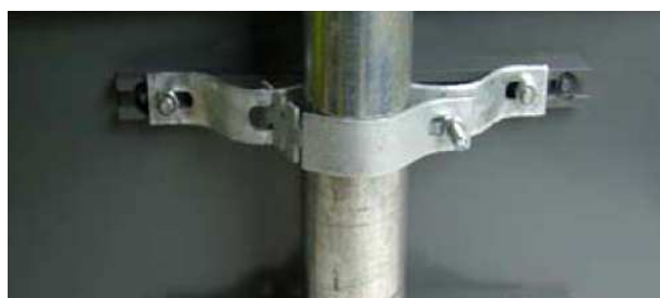
Fot. 3. Uchwyt uniwersalny przykręcony do słupka
