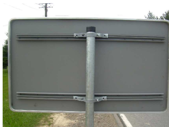
Fot. 2.8. Tablica zamontowana do słupka – widok od strony tylnej
