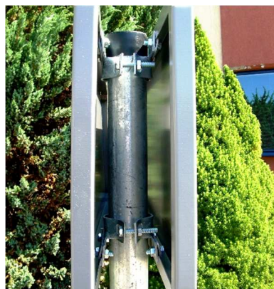
Fot. 3.21. Tablica dwustronna zamontowana do słupka – widok z boku
