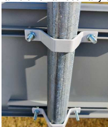
Fot. 9.2. Zamocowany uchwyt na słupku wsporczym
