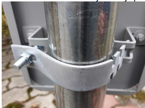
Fot. 1.8. Uchwyt „Ząbek” zamocowany na profilu
