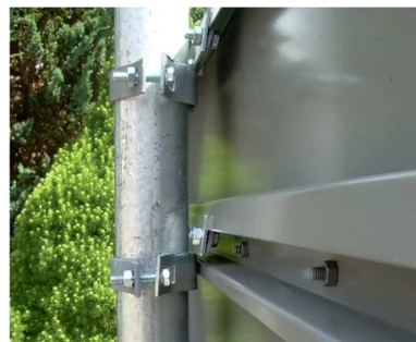
Fot. 3.10. Uchwyt typu „Zacisk” zamocowany do tablicy – widok od strony śruby
