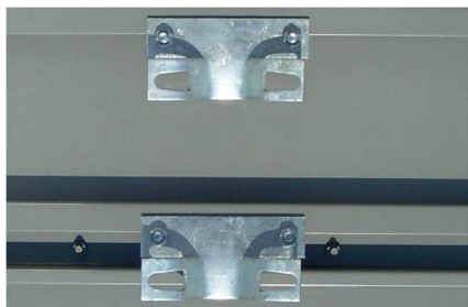
Fot. 3.8. Uchwyt typu „Zacisk” zamocowany do profilu
