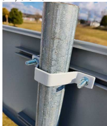
Fot. 9.4. Uchwyt "Cybant" - widok od strony prawej
