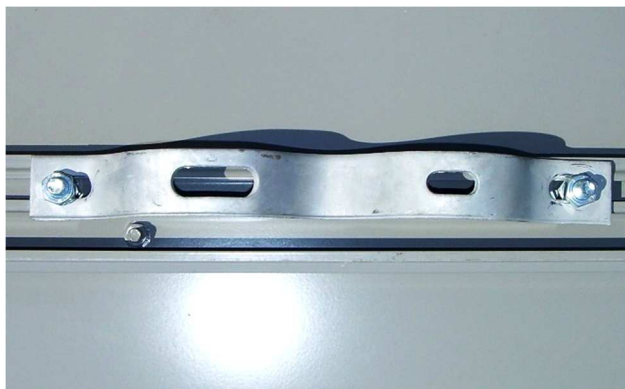
Fot. 2.5. Uchwyt zamocowany do profilu na tablicy
