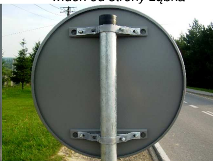
Fot. 2.12. Uchwyt uniwersalny – widok od strony tylnej
