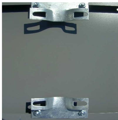
Fot. 3.19. Uchwyt typu „Zacisk” zamocowany do drugiego zagięcia tablicy
