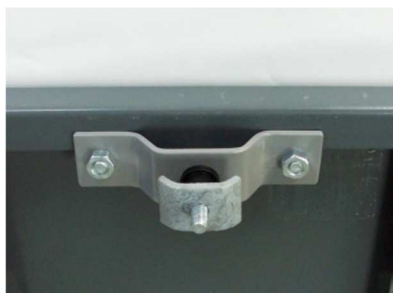
Fot. 4.2. Mocowanie do krawędzi
