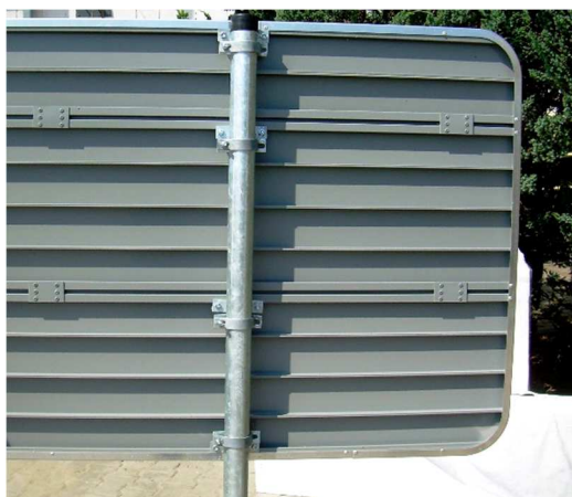
Fot. 3.15. i 3.16. Tablica zamontowana do słupka za pomocą uchwytów typu „Zacisk”
