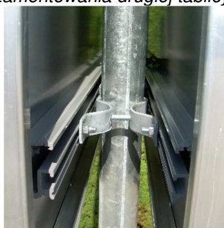
Fot. 2.18. Tablica zamontowana do słupka – widok z boku
