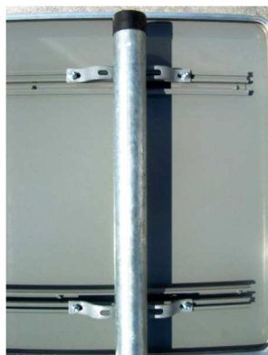
Fot. 2.15. Słupek na pierwszej tablicy przygotowany do zamontowania drugiej tablicy
