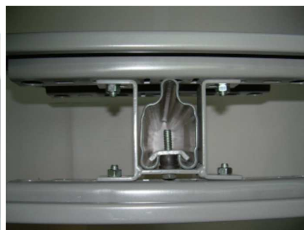
Fot. 6.4. Prawidłowo zamocowane tablice na słupku
