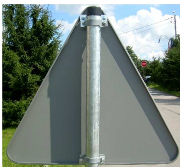
Fot. 3.6. Uchwyt typu „Zacisk” zamocowany do krawędzi znaku
