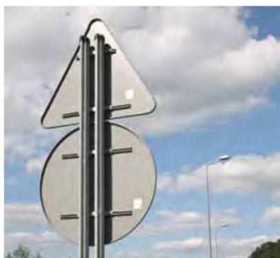
Fot. 5.1. Zamontowane znaki na słupkach
