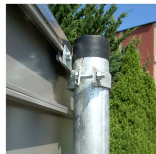
Fot. 3.14. Tablica zamontowana do słupka – widok od strony śruby
