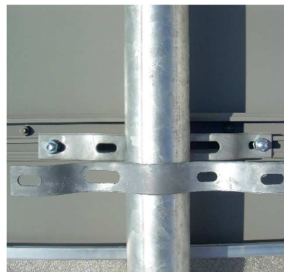
fot. 2.16. Sposób ułożenia uchwytów typu „Fala” względem siebie
