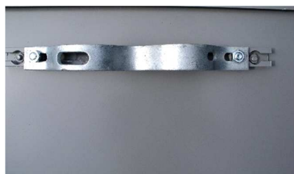
Fot. 2.2. Uchwyt uniwersalny zamocowany na profilu
