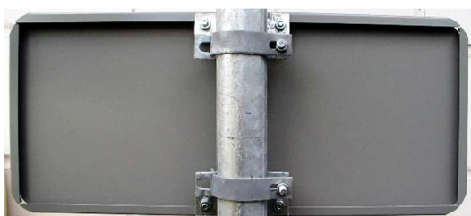
Fot. 3.7. Uchwyt typu „Zacisk” zamocowany do krawędzi tablicy
