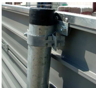
Fot. 3.13. Tablica zamontowana do słupka – widok od strony ząbka
