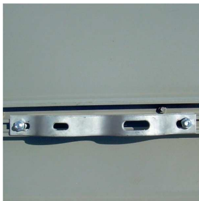
Fot. 2.14. Uchwyt zamocowany do profilu na tablicy
