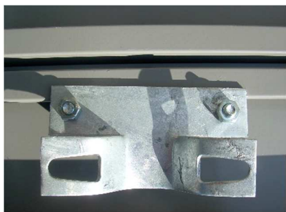
Fot. 3.12. Uchwyt zamocowany do profilu montażowo- usztyniającego
