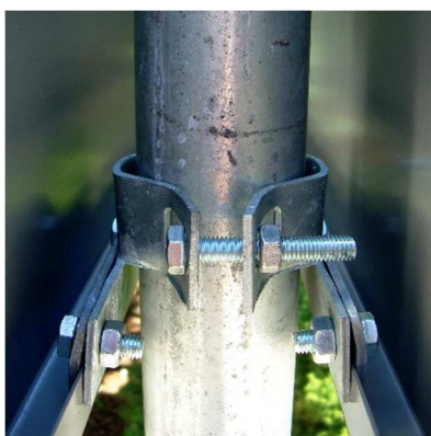
Fot. 3.23. Tablica dwustronna zamontowana do słupka – widok z boku
