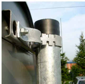
Fot. 2.10. Uchwyt uniwersalny – widok od strony zębka
